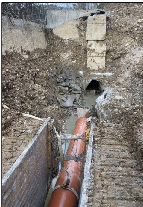
Figura 5 Loc. La Cartaita – Vaiano – messa in sicurezza e ripristino della fognatura passante in alveo al fiume Bisenzio, sotto i fabbricati residenziali in prossimità di via del Greto. In
