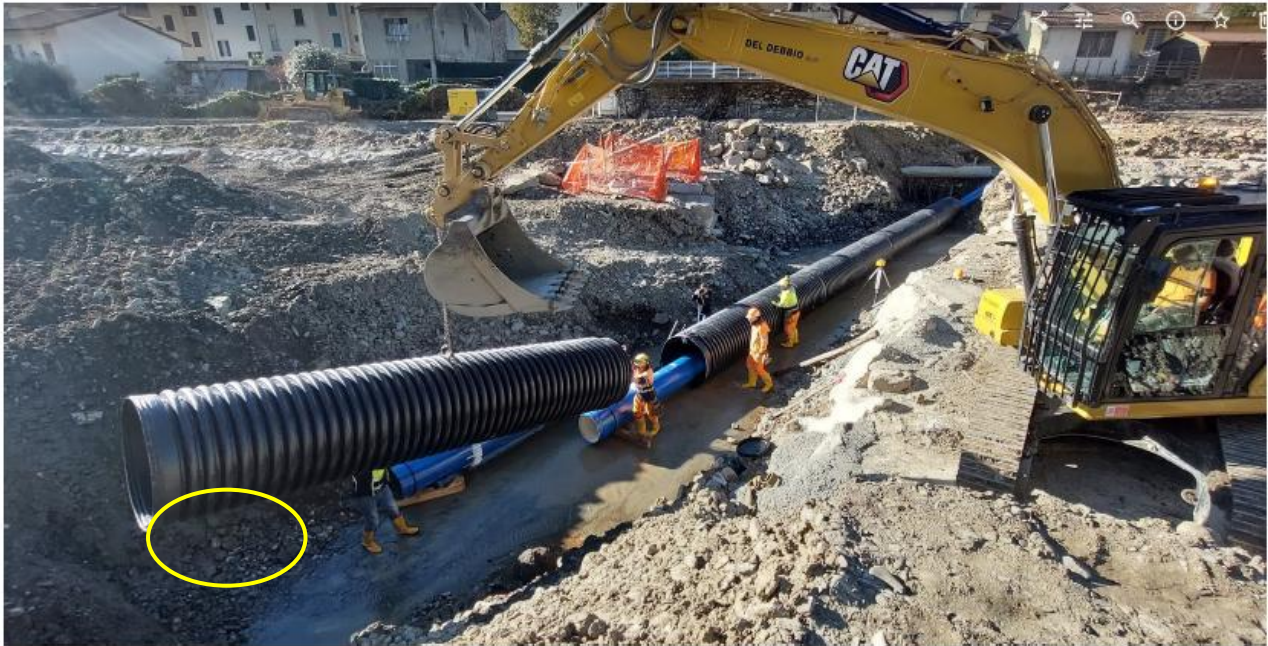
Figura 1 Ripristino adduzione Loc. Tignamica - attraversamento fiume Bisenzio - Vaiano
