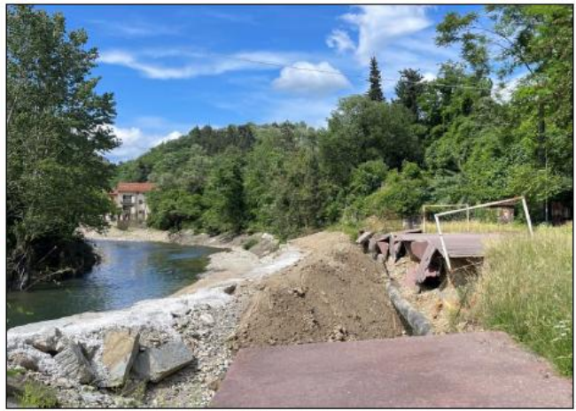
Figura 1 Ripristino adduzione Loc. Tignamica - attraversamento fiume Bisenzio - Vaiano
