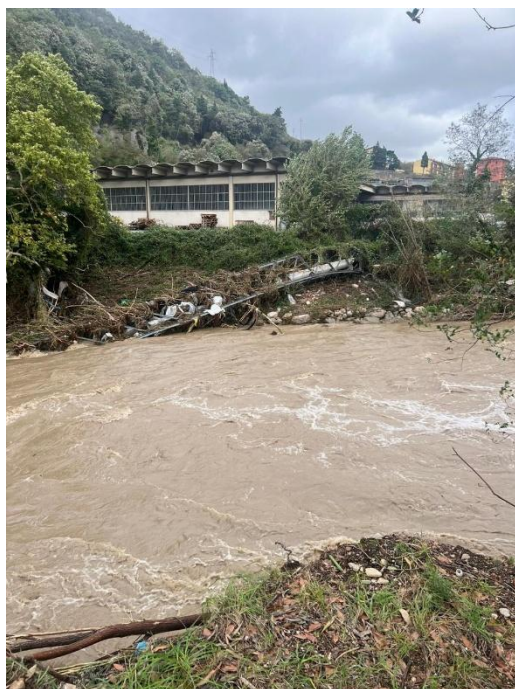
Figura 3 - Loc. Camino – Vaiano – ripristino condotta fognaria divelta dal fiume Bisenzio; In ordine orario si riporta lo stato dei luoghi e il completamento del ripristino della continuità idraulica dell'infrastruttura fognaria mediante la realizzazione di un punto tubo.
