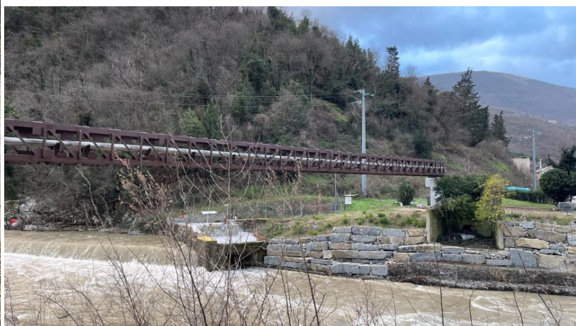
Figura 3 - Loc. Camino – Vaiano – ripristino condotta fognaria divelta dal fiume Bisenzio; In ordine orario si riporta lo stato dei luoghi e il completamento del ripristino della continuità idraulica dell'infrastruttura fognaria mediante la realizzazione di un punto tubo.
