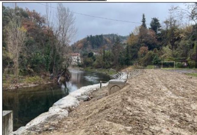
Figura 2 Ripristino adduzione Loc. Cartايا - In ordine orario si riporta lo stato dei luoghi: 1) a seguito dell'evento; 2) durante i lavori; 3) completamento del ripristino della sicurezza dell'infrastruttura acquedottistica mediante la sistemazione della sponda del Fiume Bisenzio.
